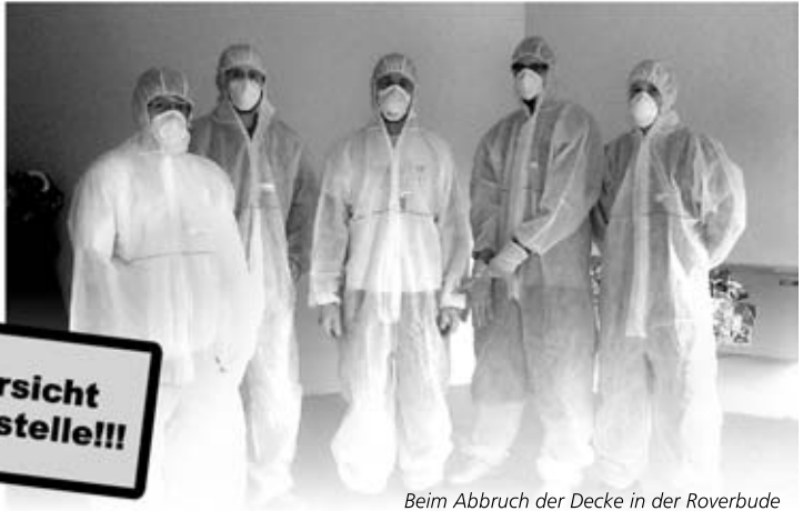
Beim Abbruch der Decke in der Roverbude
